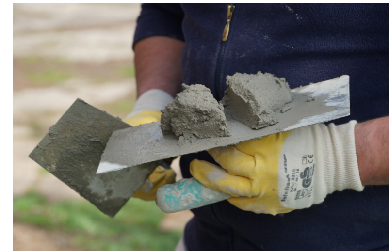
Mit dem Mörtel spachtelt Alasfar die abgebröckelte Backsteinwand zu. In Syrien hat er hauptsächlich mit Gips gearbeitet. Auch die Werkzeuge sahen ein bisschen anders aus
